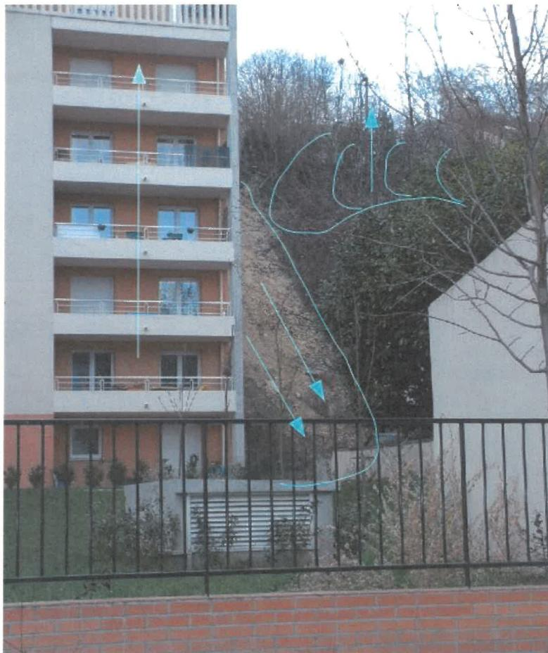
*Glissement des terrains superficiels sur une pente raidie par l'exploitation du Calcaire Grossier
